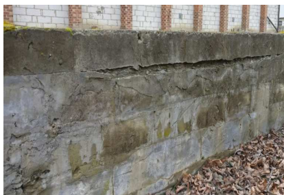
Ubytki zaprawy
