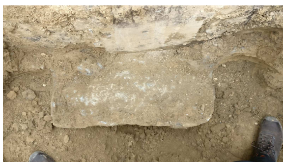
Stopa fund. do poszerzenia (wg. rys. fundamentów)
