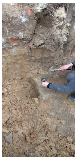
Ściany fundamentowe z betonu
