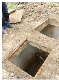
Stopa fund. do poszerzenia (wg. rys. fundamentów)
