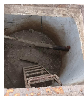
Stopa fund. do poszerzenia (wg. rys. fundamentów)
