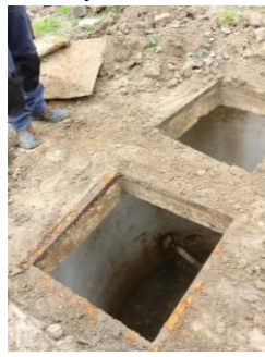
Stopa fund. do poszerzenia (wg. rys. fundamentów) Studnia dawnego ujęcia wody – odkryta podczas ekspertyzy fundamentów
