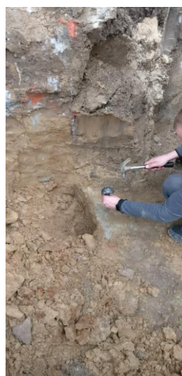
Badanie wytrzymał. betonu
