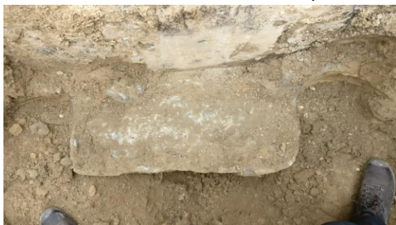
Stopa fund. do poszerzenia (wg. rys. fundamentów) Studnia dawnego ujęcia wody – odkryta podczas ekspertyzy fundamentów
