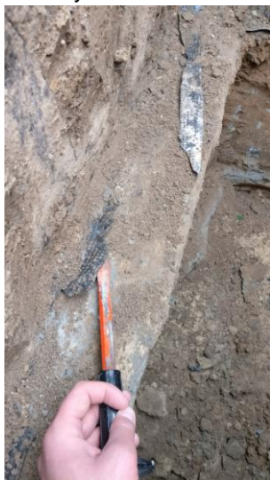
Miejscowa izolacja pozioma
