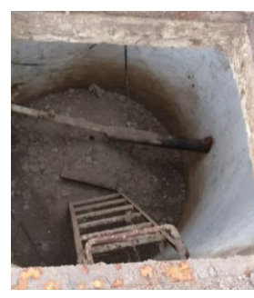
Stopa fund. do poszerzenia (wg. rys. fundamentów) Studnia dawnego ujęcia wody – odkryta podczas ekspertyzy fundamentów
